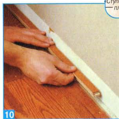
10 Неодинаковый зазор между полом и стеной можно выровнять, установив планки разной ширины.
