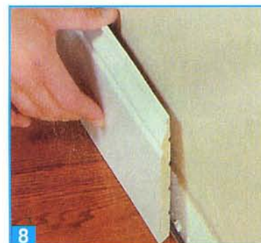
Зазоры по периметру пола закрывают плинтусами и молдингами.
