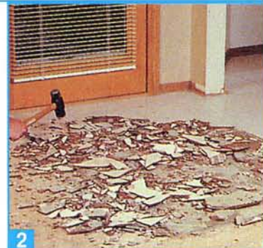
2 При необходимости с пола удаляют кафельные плитки.
