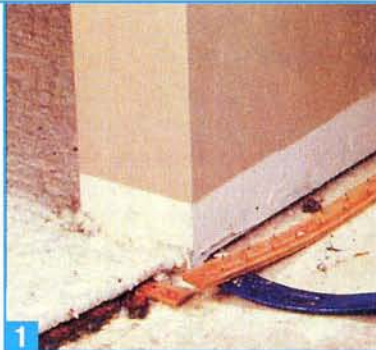
1 Подготовку чёрного пола начинают с удаления, крепящих ковёр планок.
